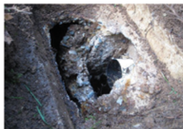
nepravilno vzdrževanje greznice
